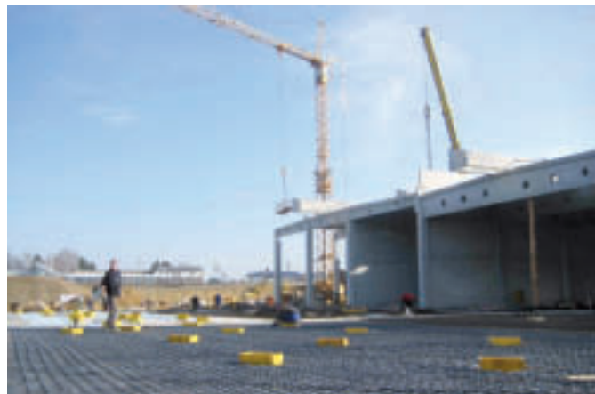
Bild 1. GFK-Bewehrung im Bereich der zukünftigen Signalanlagen
